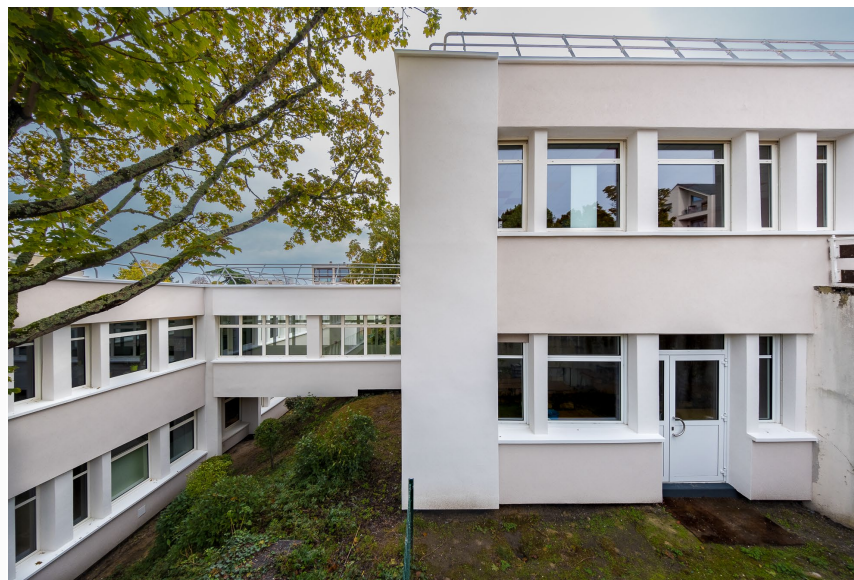
Réhabilitation d'un groupe scolaire à Rueil Malmaison
