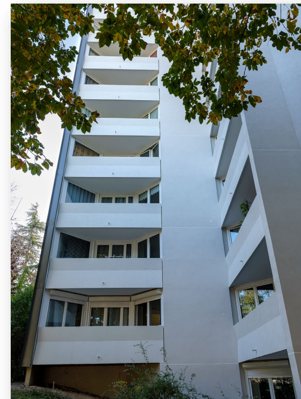
Réhabilitation de 18 bâtiments à Saint Germain en Laye
