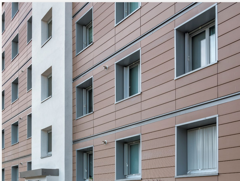
Réhabilitation des 100 logements de la résidence Jules Ferry à Juvisy-sur-Orge
